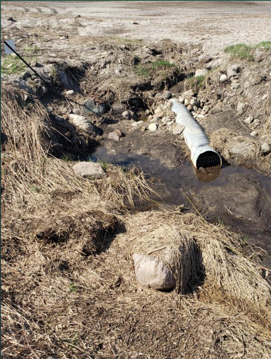
Existing outlet pipe (erosion)
